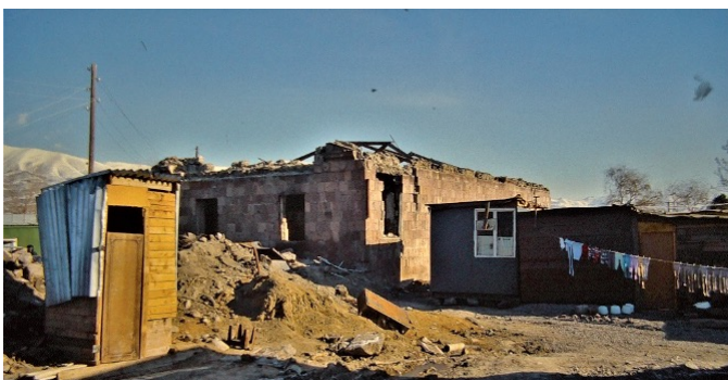
Mange boede i skurvogne ved siden af deres ødelagte hus, med toilet på gaden.
